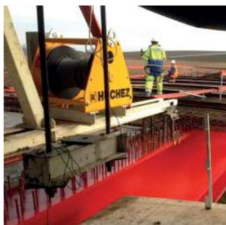
▷ Installation d'un coffrage sur un chantier.
