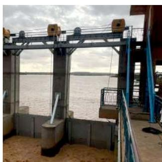
△ Industria 8 t installés sur des vannes de chasse d'un seuil de retenue d'eau.
