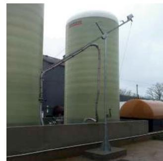
△ Déploiement d'un bras de chargement.
