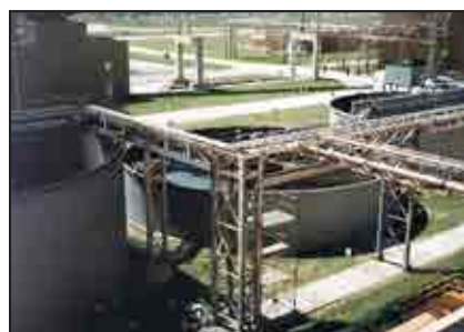
L'un des quatre réservoirs à revêtir
