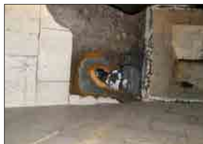
Rupture de la goulotte revêtue de tuiles après 4 mois, avant le rebouchage
