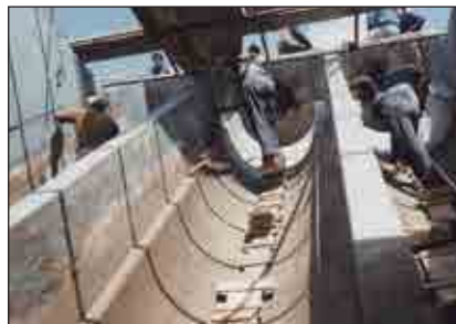
ARC 791 appliqué sur les surfaces convenablement préparées
