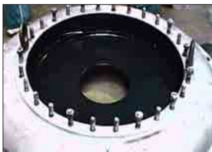
Installation d'ARC 855 dans la volute de pompe
