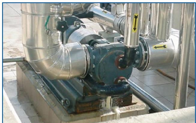
Pompa installata in un impianto per produzione di detergenti
